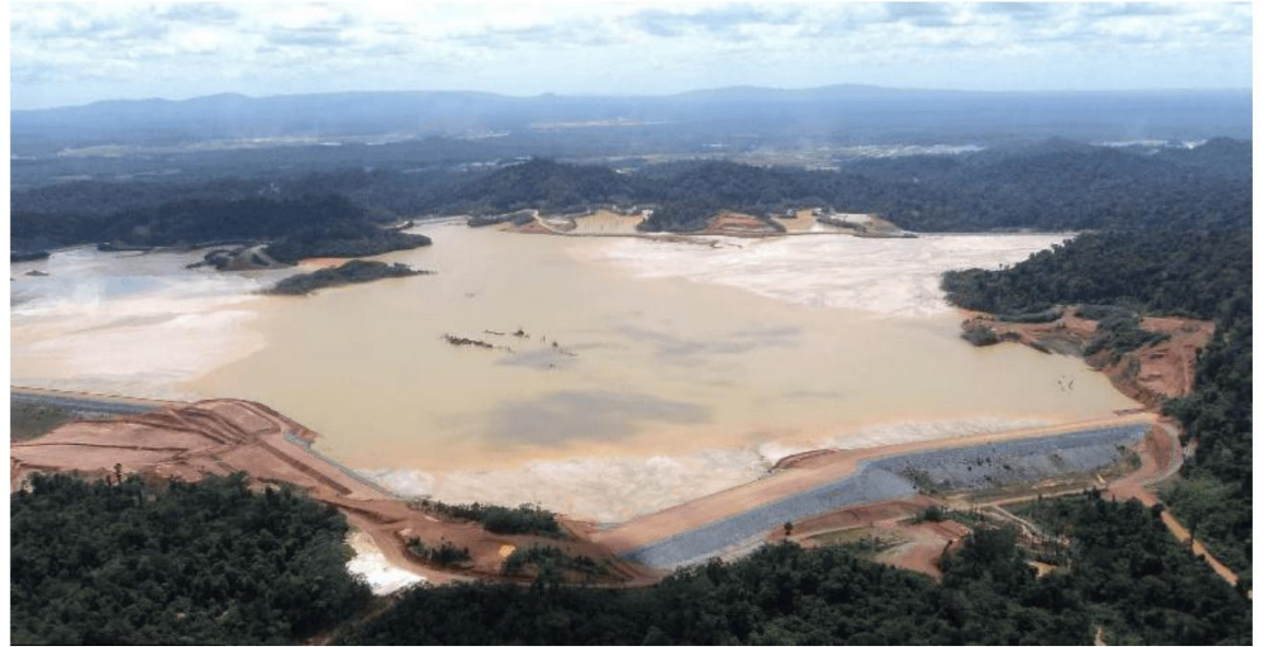
Parc à résidus contenant des effluents cyanurés, mine d'or de Rosebel
